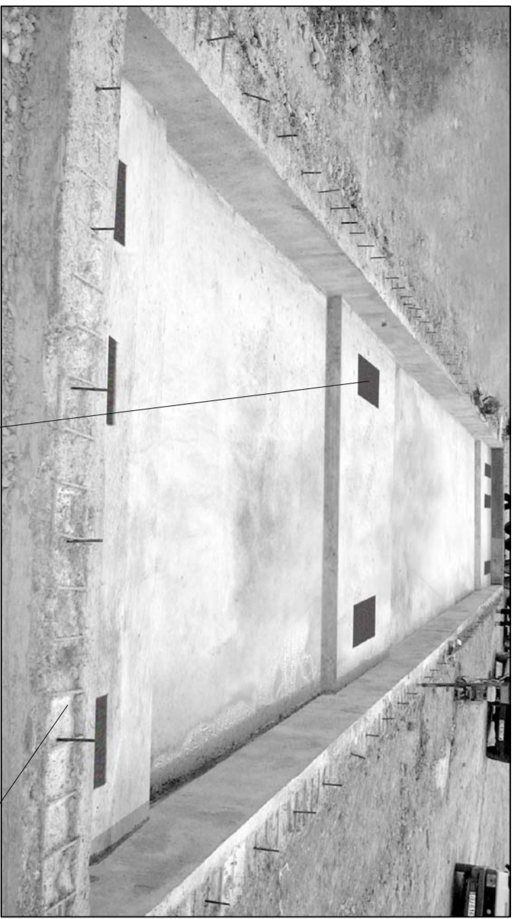
VISTA OBRA CIVIL MURO PERIMETRAL BASCULA PENDIENTE DE HORMIGONAR 10 cm. SUPERIORES.
